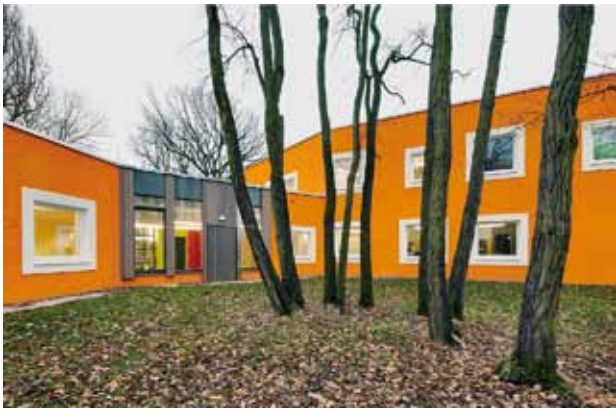
Das Gebäude ist in einen Massivbau und einen Holzskelettbau gegliedert. Diese Gliederung ist an den großen und kleinen Fenstern erkennbar sowie an der unterschiedlichen Farbigkeit
